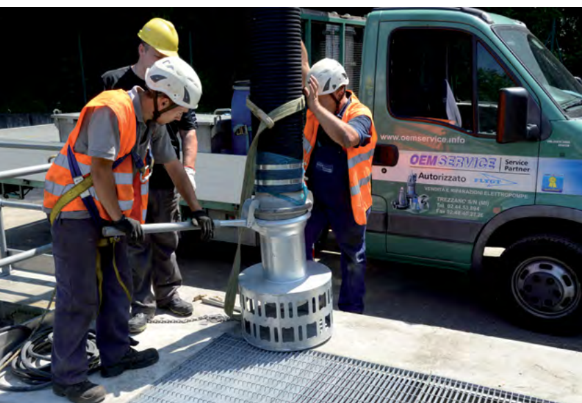
Dotazioni tecniche all'avanguardia ed esperienza sul campo sono fondamentali per realizzare bypass affidabili
