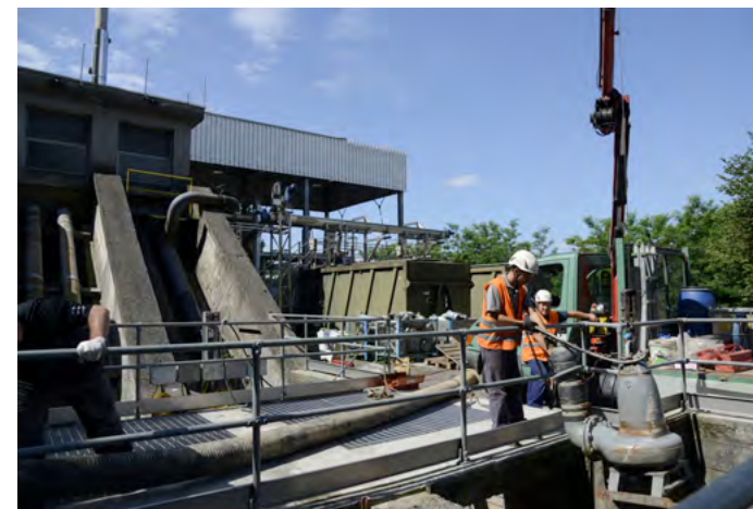
Le pompe NS di Xylem possono essere immerse direttamente, senza la necessità di ulteriori opere
